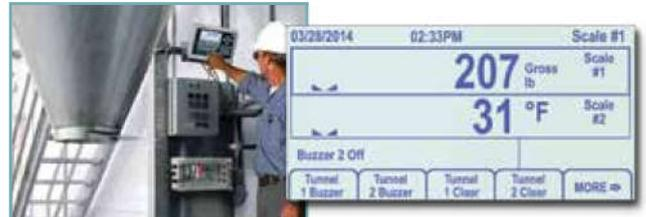
Um display para duas balanças oferece opções de visualização de uma ou duas balanças de cada vez. A entrada analógica e a placa para termopar opcional permitem que você monitore o peso, temperatura ou outros sensores simultaneamente.
